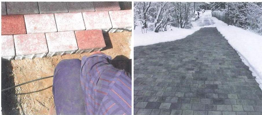
**Schnee ade:** Die Heizleitungen verlaufen in Nuten, die jeweils in die Steine gefräst werden – und liegen nur 2,5 bis 3 Zentimeter unter der Oberfläche.
