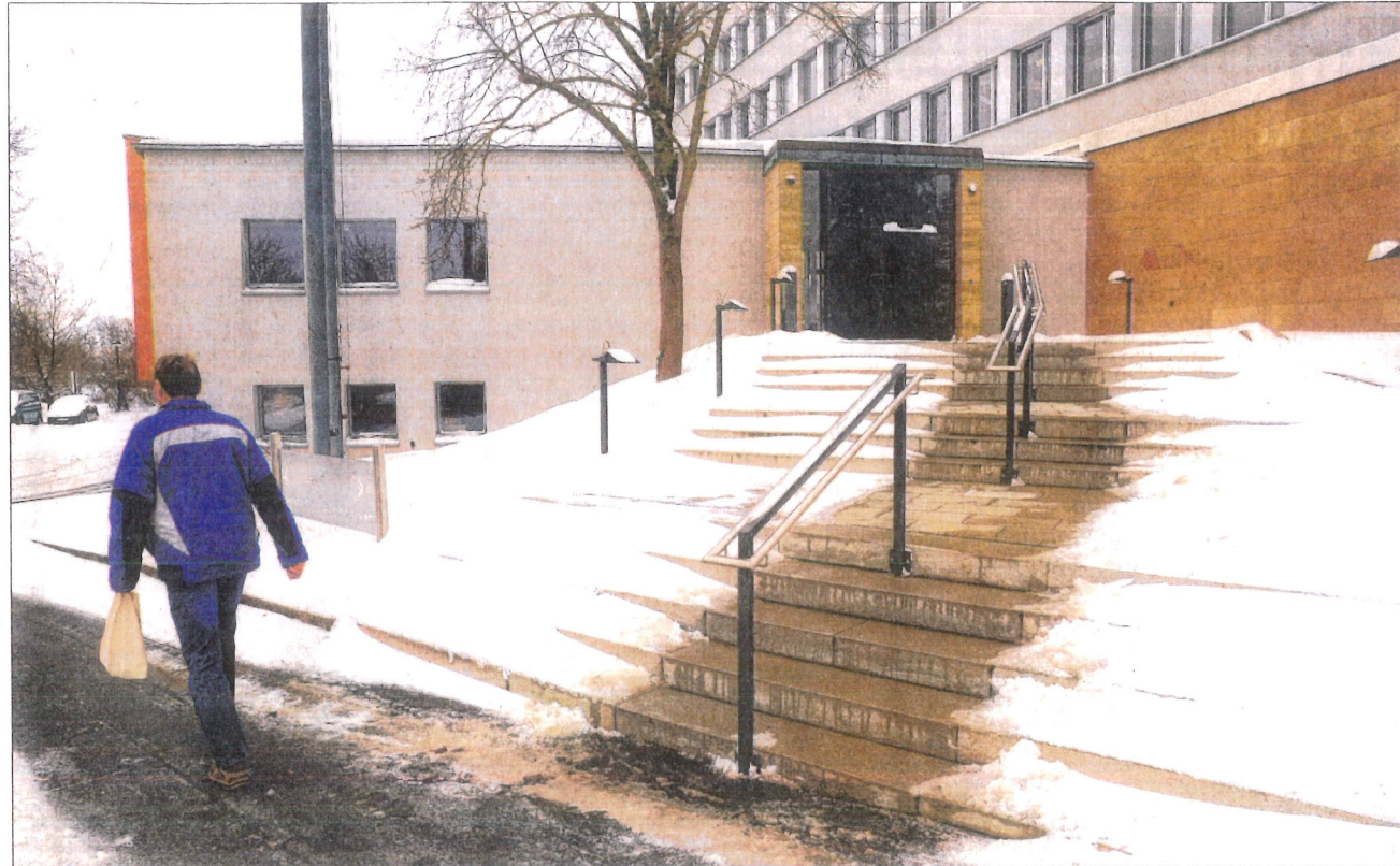
Kein Ergebnis mühsamen Schneeschippens: Der rund 1,50 Meter breite, schneefreie Streifen auf der Treppe des Amtes für Ländliche Entwicklung ist der sich automatisch einschaltenden Heizung in den Stufen zu verdanken. F.: Albright
