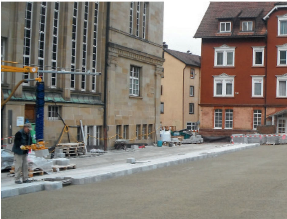
Abbildung 1: Am Rathaus der Stadt Schramberg im Schwarzwald werden aktuell 1.800 m 2 mit dem Lapis Perfectus in ungebundener Bauweise gemäß Bauklasse III verlegt. Fotos und Abbildungen: Der Stein
