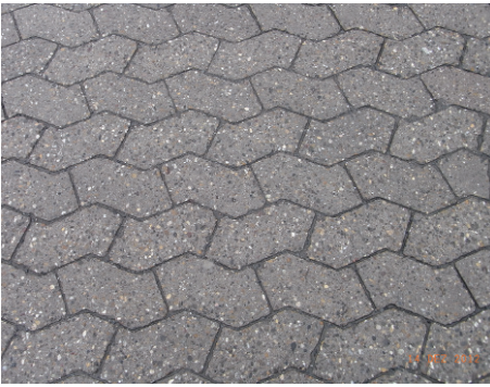
Abbildung 3: Ein SF-Pflasterverbund mit nur 3mm Fugenbreite hat eine sehr hohe Stabilität ...
