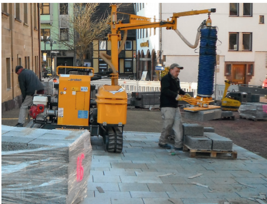
Abbildung 12: Mit Hilfe eines Vakuum-Saugers konnte der Lapis Perfectus in Schramberg maschinell gesetzt werden
