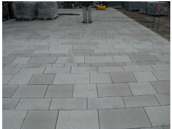
Abbildung 10: Der fertig verlegte Lapis Perfectus zeichnet sich durch eine sehr enge Fuge und eine sehr fußgängerfreundliche plane Oberfläche aus
